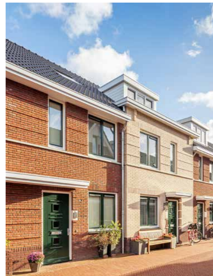
Nieuwbouw 146 woningen Remise, Haarlem Opdrachtgever Hoorne Vastgoed & Pré Wonen
